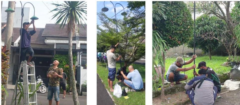
Gambar 3. Pemasangan Tiang PJU dan Smart LED
