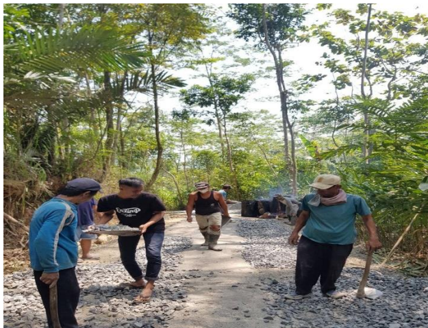
Gambar 7. Pengaspalan Jalan Desa
